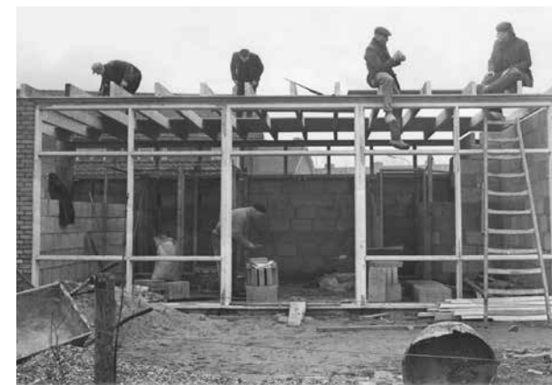
• Maart 1964: Kantine en kleedkamers in aanbouw aan de Van Houtenlaan te Ittersum.
