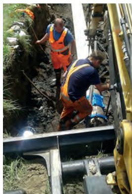
• Foto links: samen met een groep monteurs in opleiding, een reparatie aan een 500 mm hoofdwatervleidingbreuk in de Veerallee...
